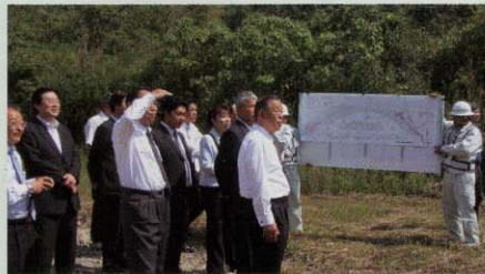
宮津野田川道路野田川IC予定地 現在整備中の宮津野田川道路について進捗状況・事業計画について説明を受け、工事現場を視察しました。
