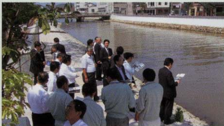
大手川改修工事現場(宮津市) 平成16年の台風23号で浸水被害が発生した大手川の災害防止のための河川改修について説明を受けました。
